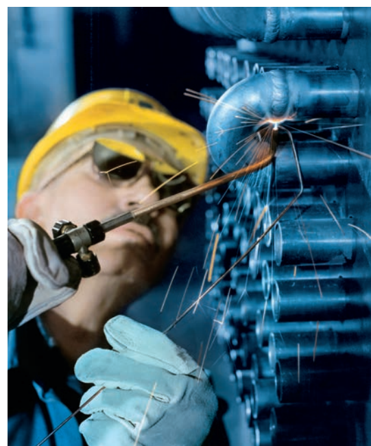
Gassveising på varmeveksler.
