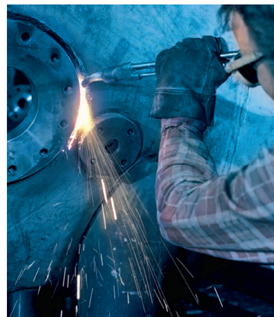
Furebrenning før sveising av baksiden.
